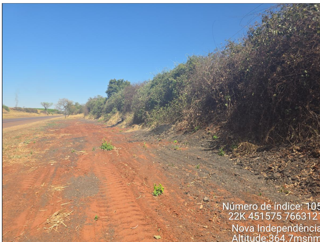
Foto 2 – Área em faixa de domínio com talude e solo exposto junto à Formação Vale do Rio do Peixe constituída predominantemente por arenitos finos a médios, pouco consolidados.
