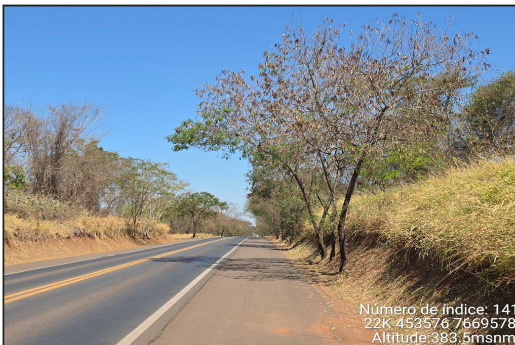
Foto 4 - Corpo estradal inserido em relevo de colinas amplas e baixas da unidade geomorfológica Planalto Centro Ocidental.
