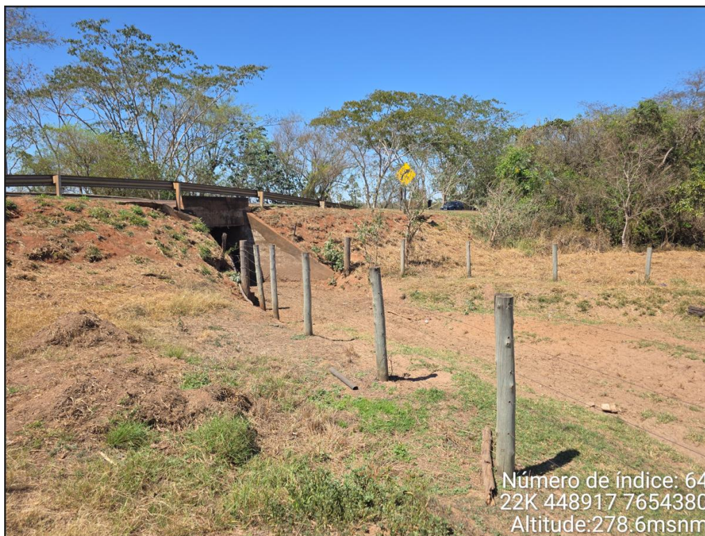
Foto 1 – Passagem de fauna com solo exposto em área de depósitos aluvionares
